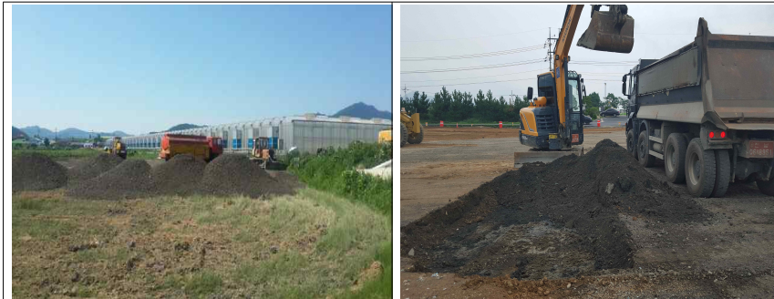
공사 초기 폐아스콘이 섞인 골재를 매립하는 모습
